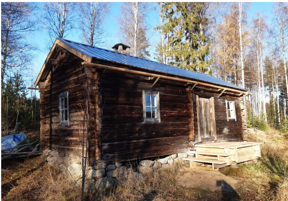
Figur 11. Stugan från söder efter omläggning av tak och uppförande av ny trappa. Foto: Daniel Olsson, 2024-10-25.
