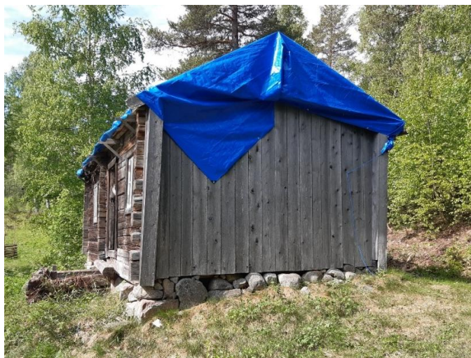
Figur 10. Vallstugan från sydöst innan renoveringen påbörjades. Foto: Daniel Olsson, 2024-05-28.
