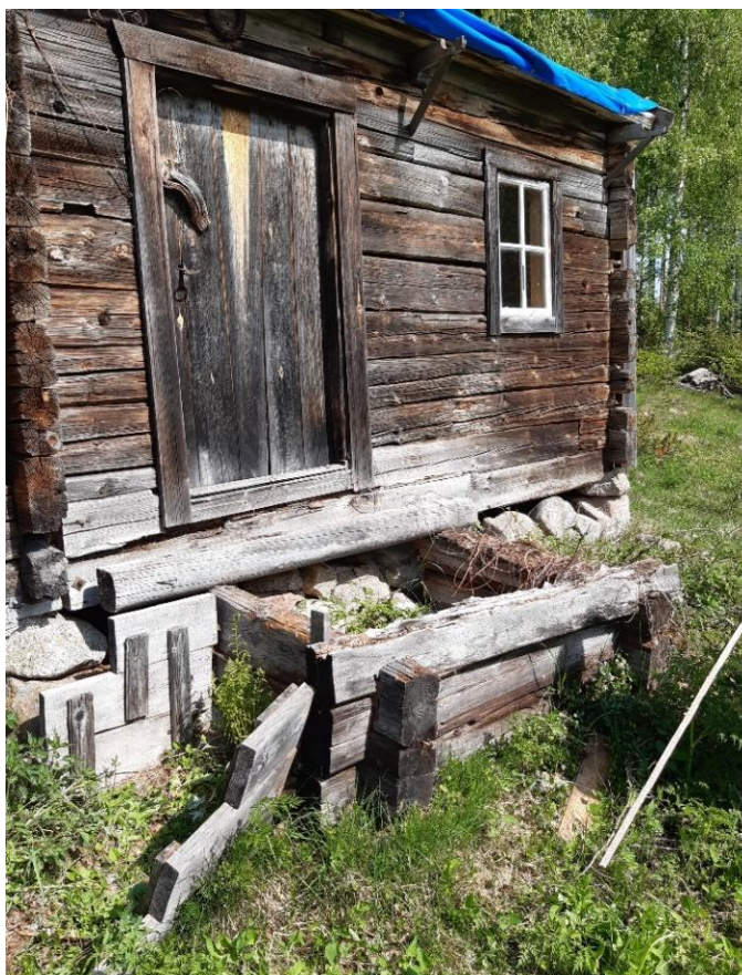
Figur 9. Trappan från söder innan renoveringen inleddes. Foto: Daniel Olsson, 2024-05-28.
