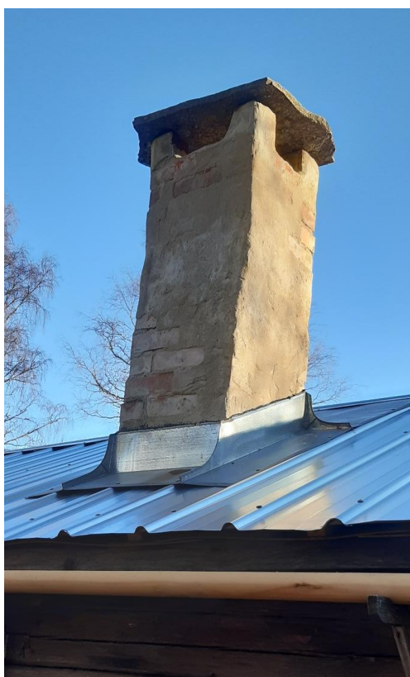
Figur 14. Skorstenen från väster efter avslutad renovering. Foto: Daniel Olsson, 2024-10-25.
