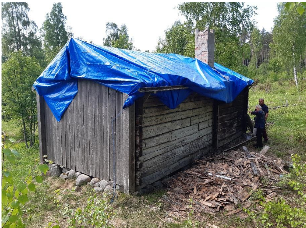
Figur 8. Vallstugan från norr. Vid byggnadens västra knut står My Leffler och Magnus Wallin. Foto: Daniel Olsson, 2024-05-28.
