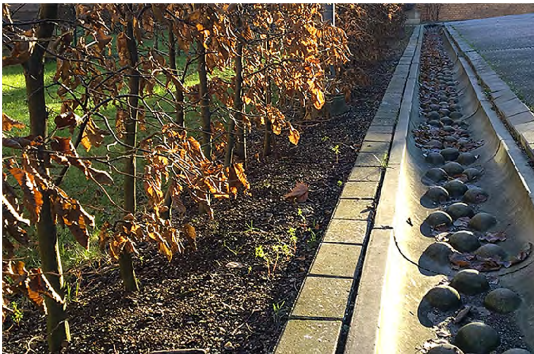
Lökrännan är ett av flera sätt att omhänderta och fördröja dagvatten lokalt. Foto Åsa Nyberg.
