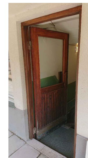
Befintliga dörrar bevaras. Byggs om till utåtgående och med dörrautomatik.
