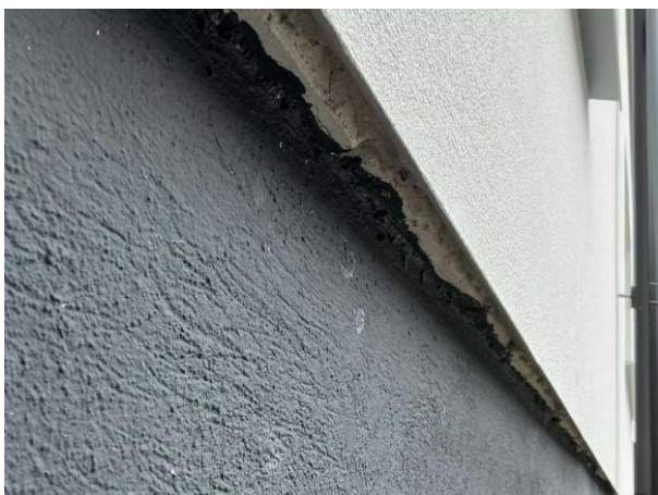
Bild 3: - Utvändigt, Fasad, putsfasad på tidigare mexitegelfasad
