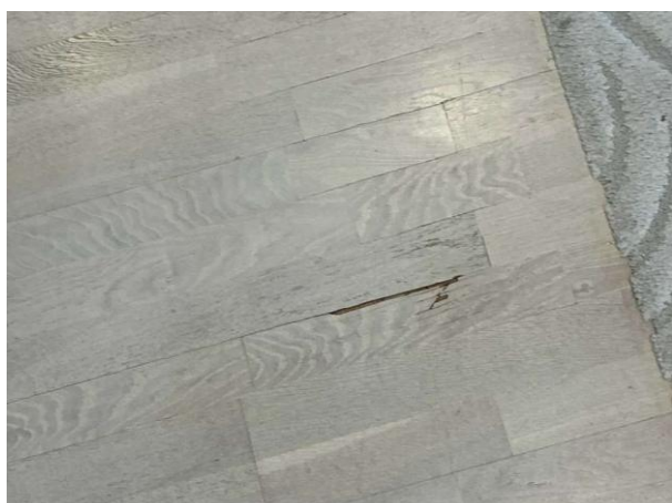
Bild 15: Invändigt, Övervåning, Spricka hål noteras i parketten
