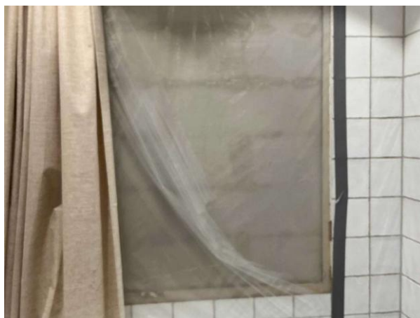
Bild 14: - Invändigt, Övervåning, Äldre våtrum Tidigare fönster är igensatt från utsidan
