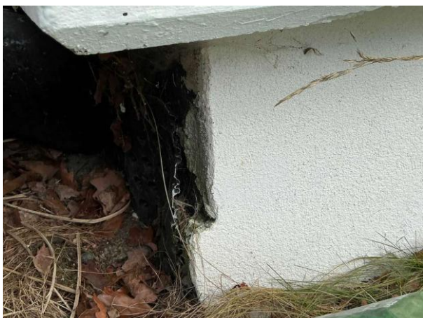
Bild 1: Utvändigt, Mark, Äldre dränering, synlig och otät platonmatta
