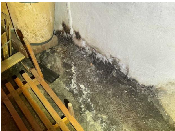
Bild 1: - Utvändigt, Grund/outgrävd/källare, Berg i dager med spår av inträngande vatten Mikrobiell påväxt noterades mot berget Visst organi...
