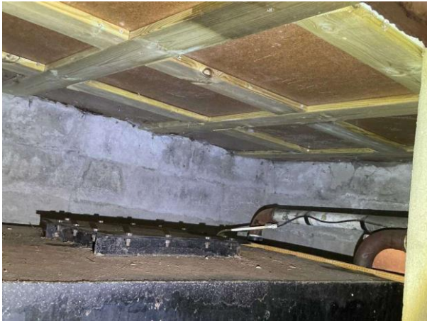
Bild 7: - Invändigt, Souterrängplan, Krypgrund utan ventiler se riskanalysen Utrymmet är besiktat från luckan Det förekommer tryckimp...
