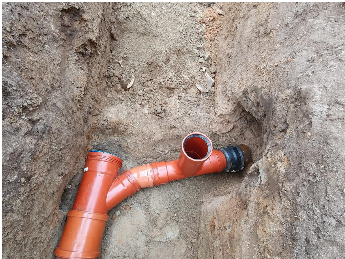
Anslutning mot befintlig avloppsledning i keramik
