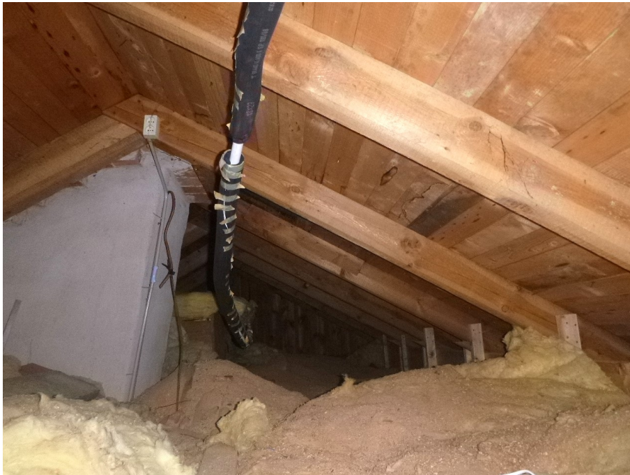
Vindsutrymme, ursprunglig del.
