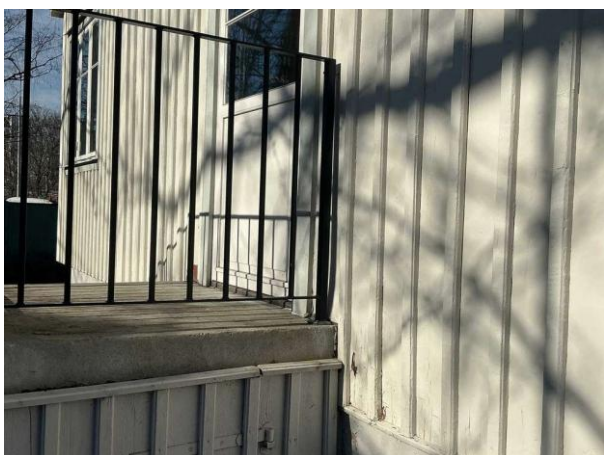
Bild 3: - Utvändigt, Fasad, Motgjutna betongkonstruktioner Längsgående
