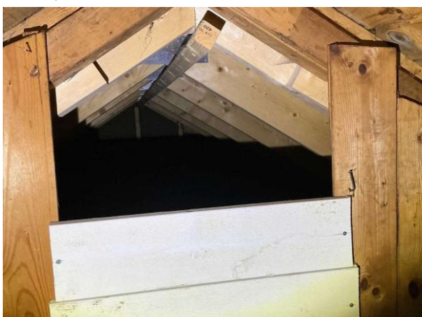
Bild 9: - Utvändigt, Vind, Vinden till tillbyggnaden är begränsad besiktigad från lucka
