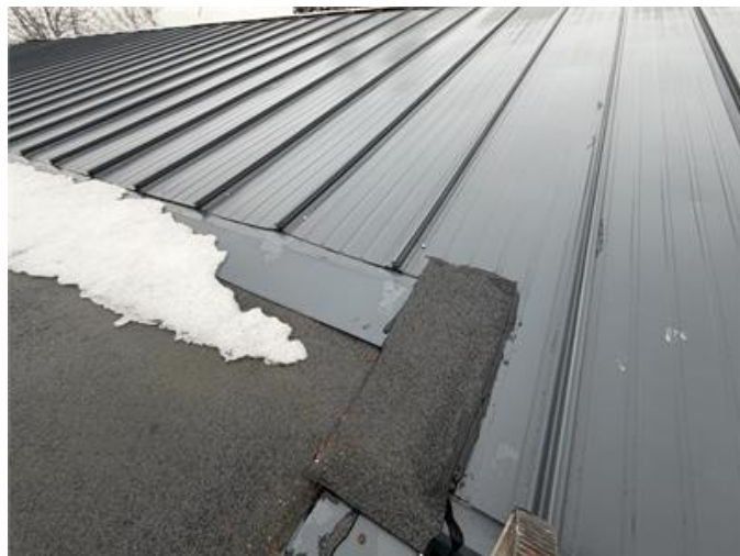
Anslutning mellan plåttak och papptak
