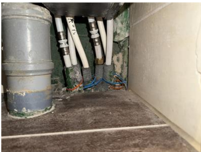
Rör genomföringar i golvet i dusch/wc
