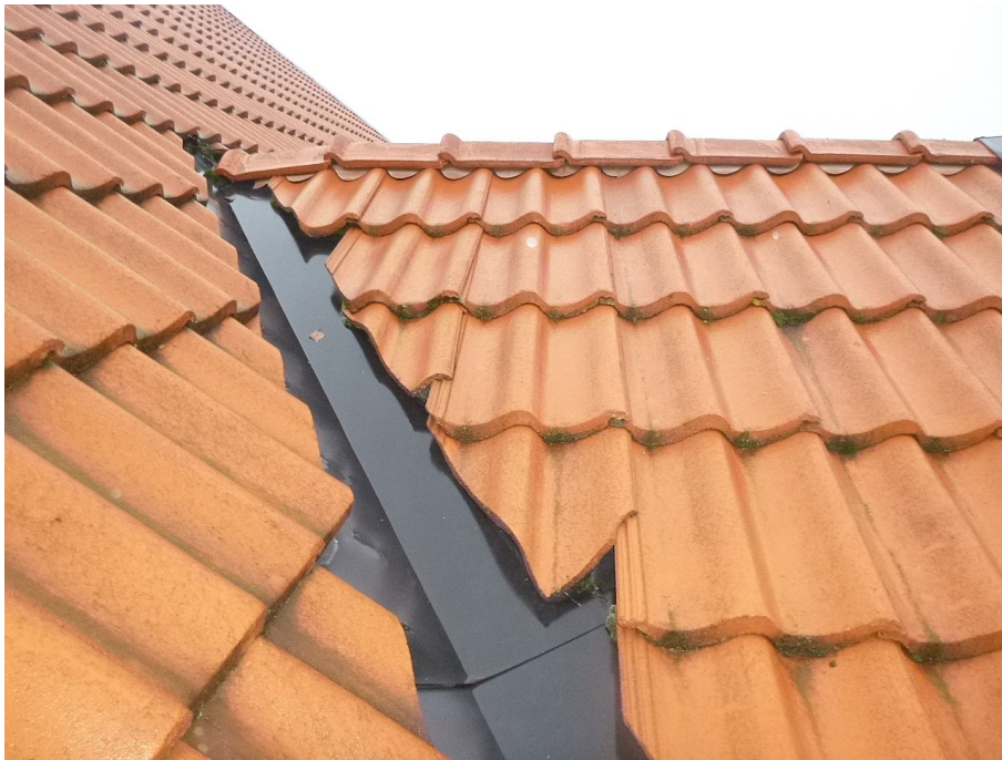
Pannor intill vinkelränna, entrétak.
