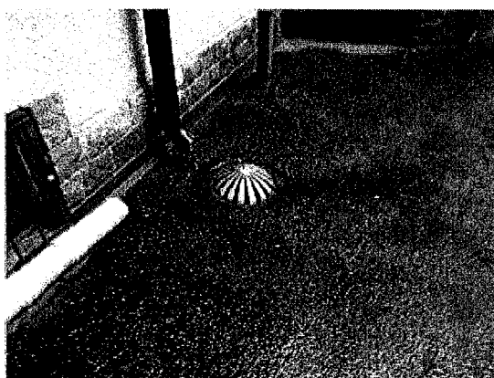
Gårdsbjälklag med brunn
